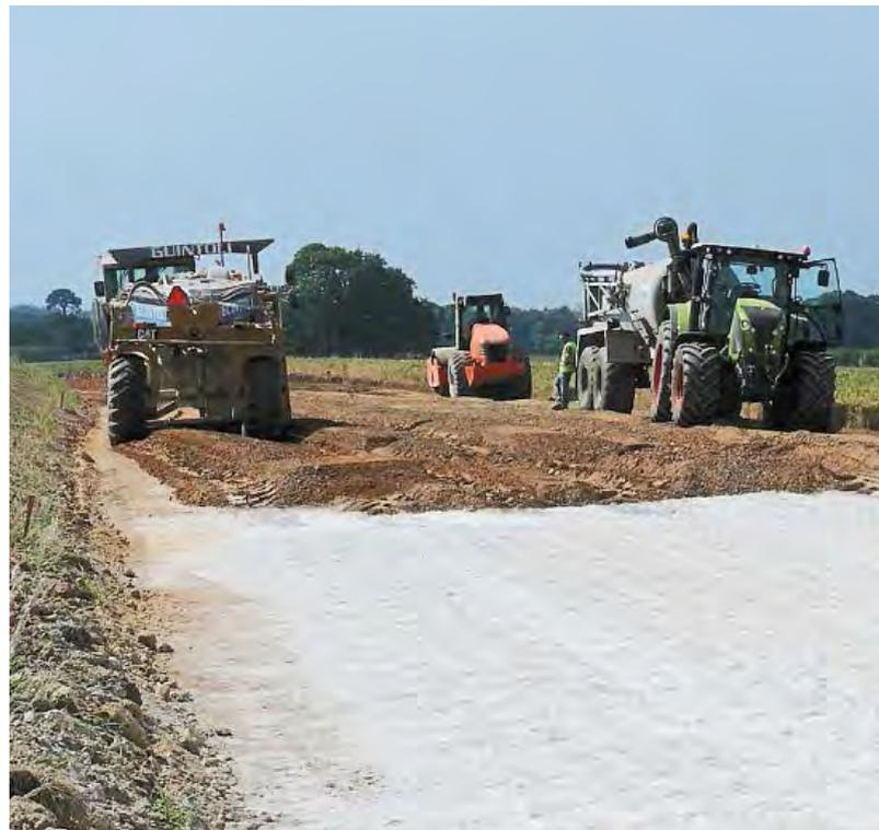
*Les déchets de chantier, mélangés à de la chaux, sont réutilisés pour construire le remblai.*
